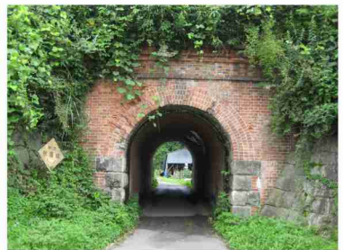
■関西鉄道架道橋
