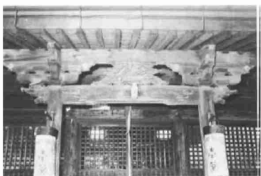
■観音院本堂正面
