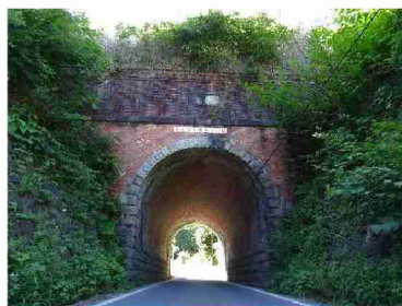
■大和街道架道橋
