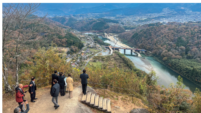
木曽川第2橋梁整備工事(苗木城跡より)
