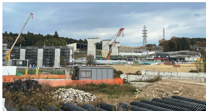
リニア駅周辺整備工事
