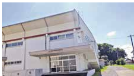
亀山東小学校体育館屋根等の改修（学校管理費・施設整備費（小学校）） 3,700万円
