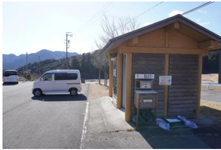
坂本棚田駐車場（7:30）
