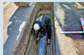
耐震管の布設作業の様子
