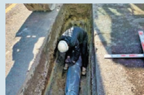
耐震管の布設作業の様子
