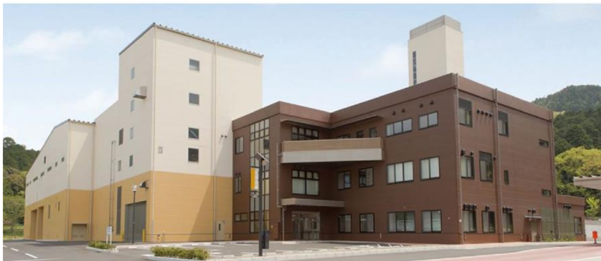
図3-3 丹波市クリーンセンター全景写真
