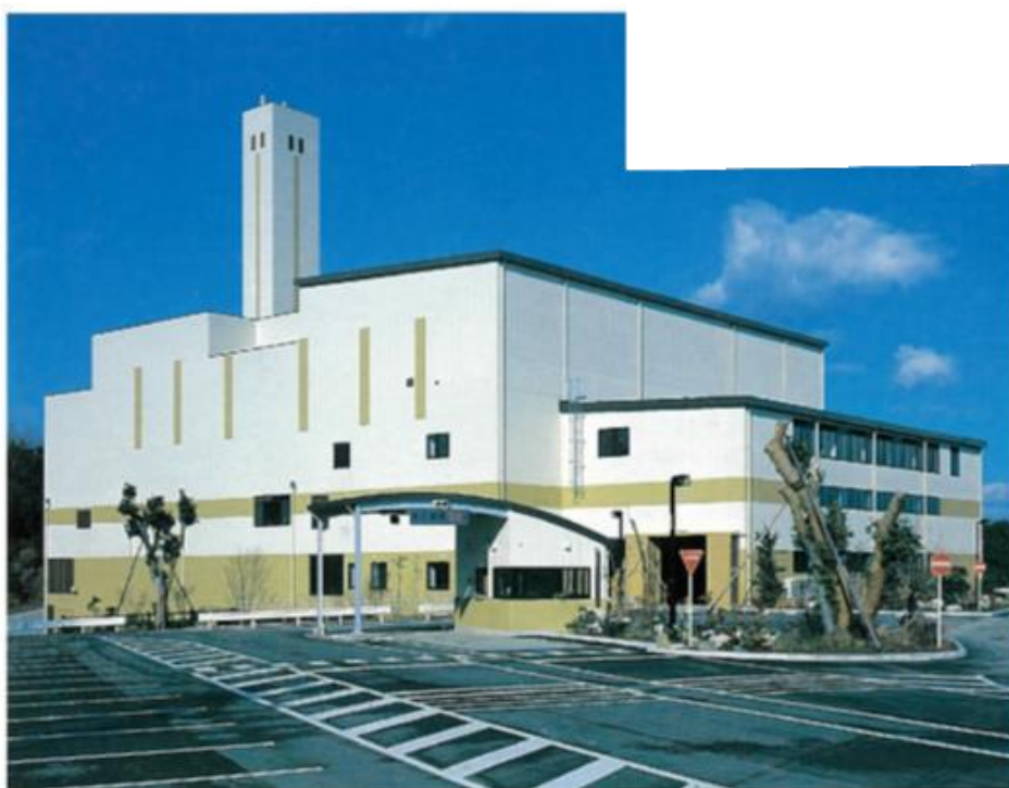
図2-1 亀山市総合環境センター全景写真
