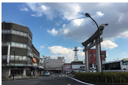
【西から敷地南側を望む〔①〕】
