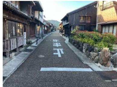
■工事完成【撮影: 令和6年10月】
