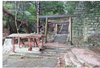
■工事完了【撮影:平成27年3月】
