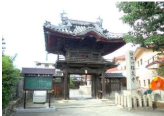
■工事着工前【撮影:平成29年7月】
