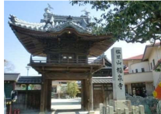
■工事完成【撮影:平成30年3月】
