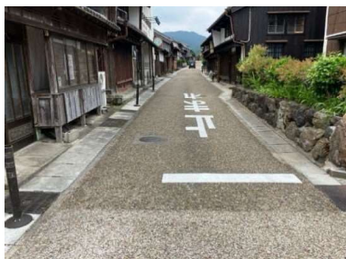
■工事着工前【撮影: 令和6年7月】
